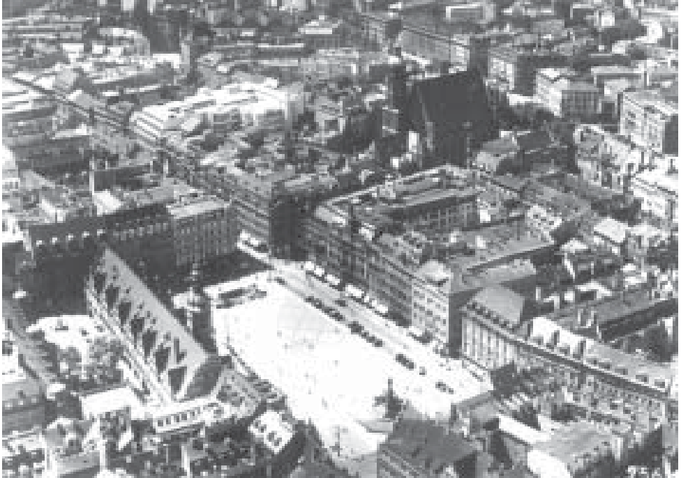
Bild 5.2: Städtebauliche Räume vor der Zerstörung: der Markt. (Quelle: Stadtarchiv)
